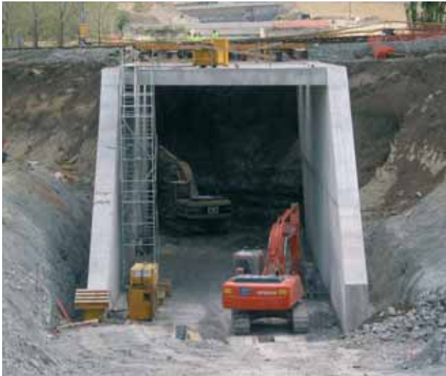
Obras sifón de Tiebas.
