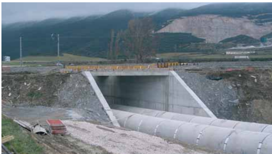
Obras sifón de Tiebas.
