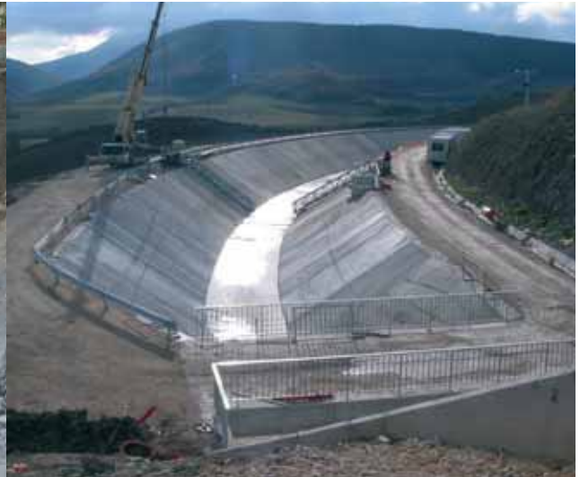
Obras balsa de Villaveta.
